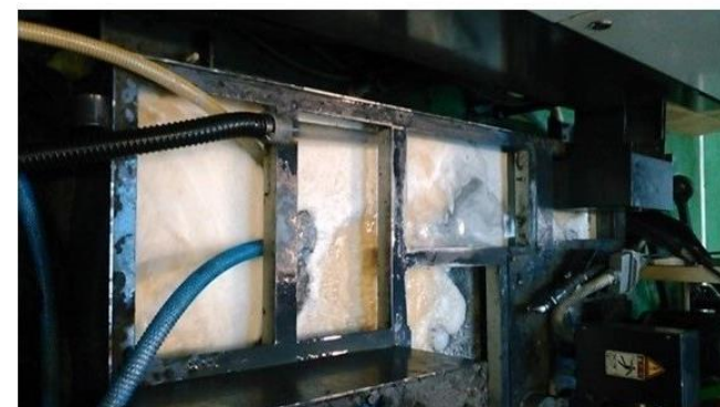
▲浮上油を回収した後のタンクで 沈殿スラッジを回収中
